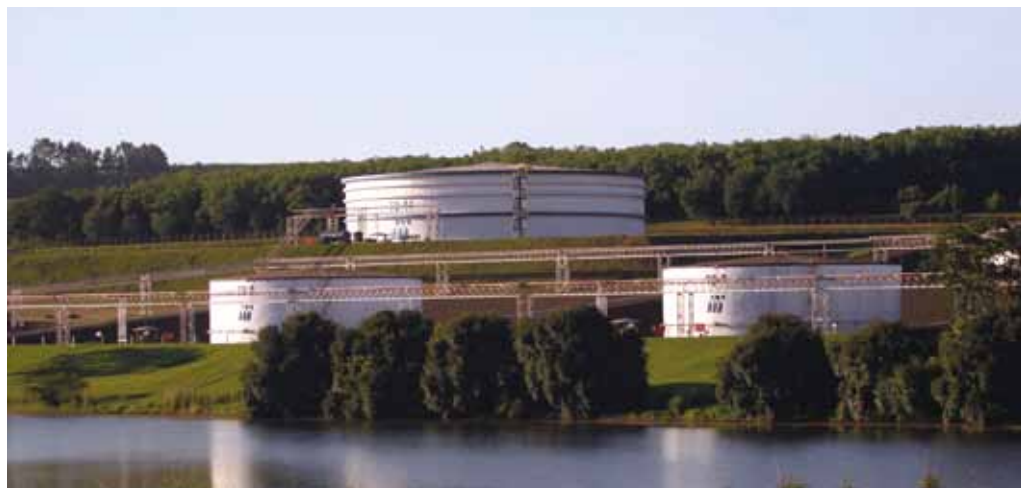
A Usina São Martinho processa o vinhoto e usa o biogás para produção de energia.
