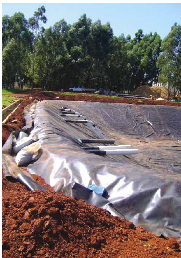
Biodigestor em construção.
